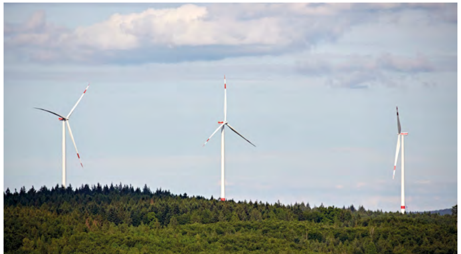
Drei von sieben fertigen Anlagen des Bürgerwindparks Südliche Ortenau
