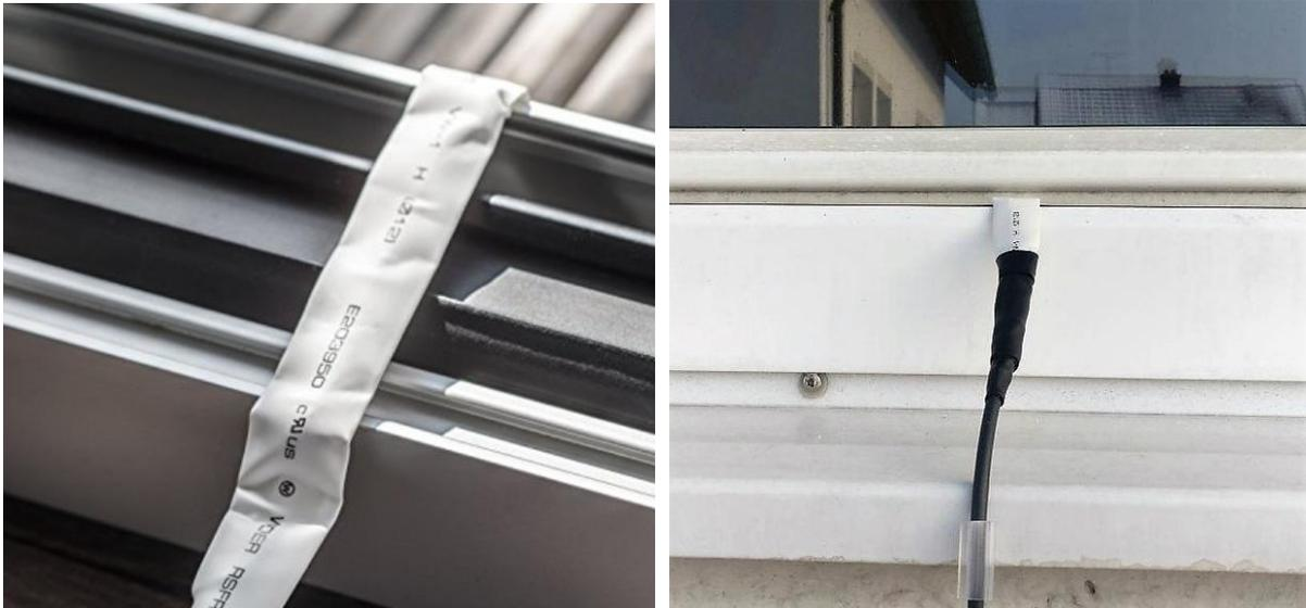
Abbildung 5: Beispiel für Fensterdurchführung des Stromkabels
