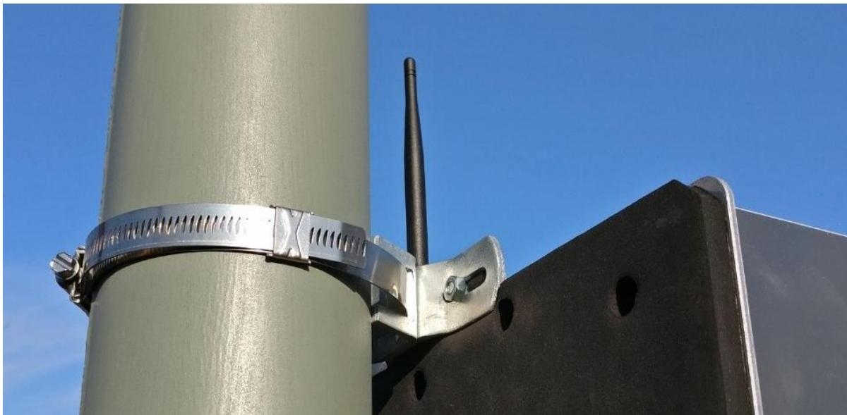
Abbildung 2: Befestigung mit Mastschelle
