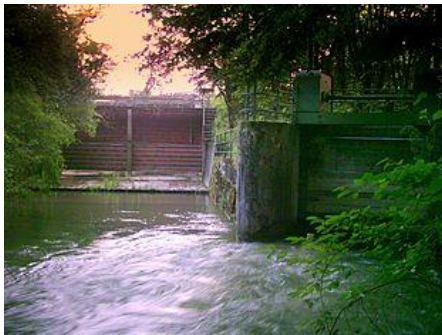
Austritt des Auer Mühlbachs aus dem Düker im Bild rechts, im Hintergrund die trockene Isarschleuse
