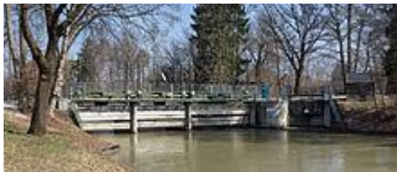
Ableitung des Auer Mühlbachs an der Wehranlage im Isar-Werkkanal
