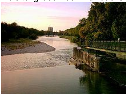
Die Kante des Wasserfalls zeigt den Verlauf des Dükers an
